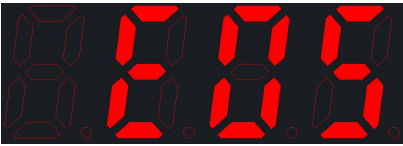
故障代号显示(外部电源故障)
