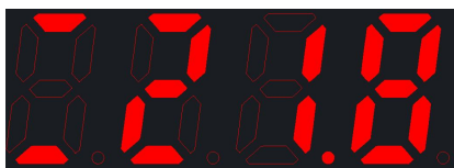
2#水泵电流值（单位：A）
