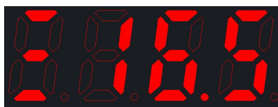
3#水泵电流值（单位：A）
