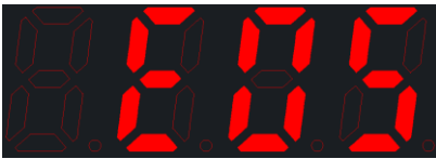
故障代号显示(外部电源故障)
