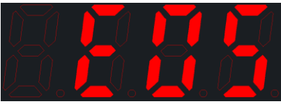
故障代号显示(外部电源故障)
