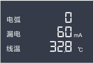
电弧0次 漏电60mA 线温32.8℃
