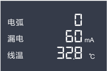
电弧0次 漏电60mA 线温32.8℃
